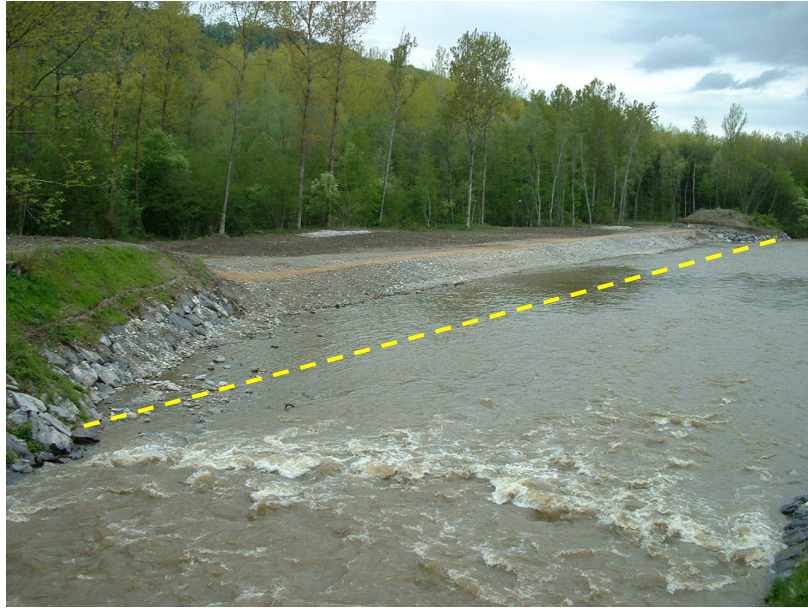
Figure 4 : Élargissement amont de la zone alluviale des Îles de Villeneuve après revitalisation (2004). Le traitillé jaune indique l'emplacement de l'ancienne digue.
