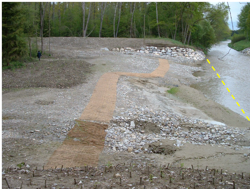
Figure 5 : Élargissement aval de la zone alluviale des Îles de Villeneuve après revitalisation (2004). Le traitillé jaune indique l'emplacement de l'ancienne digue.
