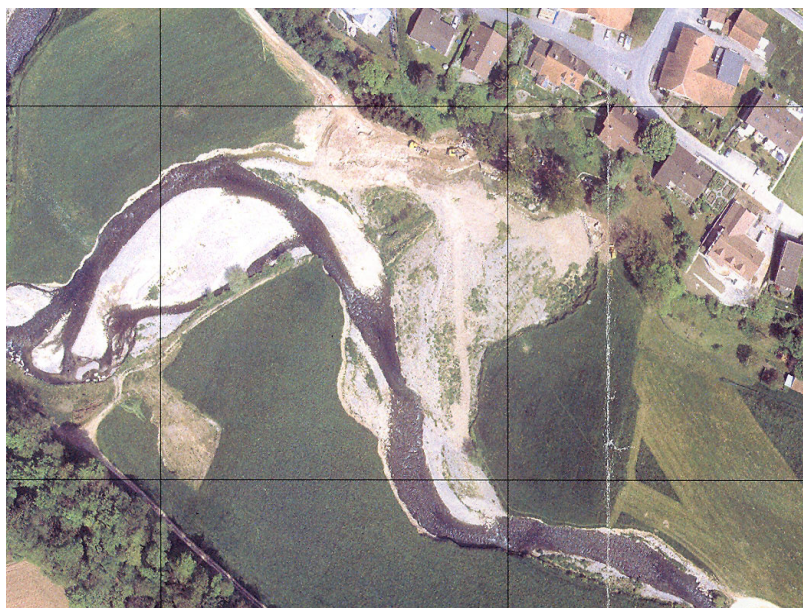
Figure 2 : Orthophoto de la Bünz près de Möriken en 2001, après sa revitalisation.
