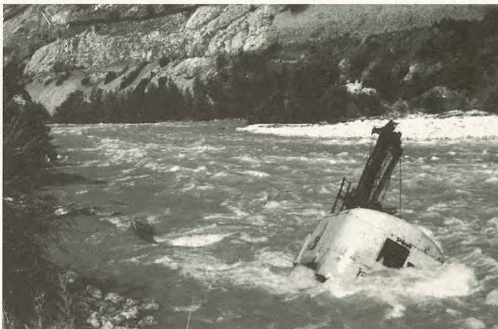
Foto 16: Pfywald (VS): Von den Fluten mitgerissene Baumaschine
