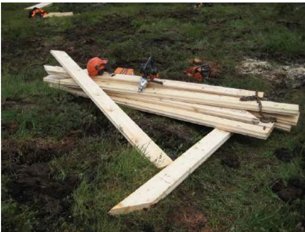
Die Spundbretter werden vor Ort abgeschragt und mit der Baggerschaufel zwischen den Führungsbalken/Zangen bis zu 3 Meter tief hinuntergedrückt, um die vor 100 Jahren angelegten Entwässerungsgräben einzustauen. Der Graben wird mit Torf eingedeckt und mit der vorher vorsichtig entfernten Vegetationsschicht zugedeckt.
