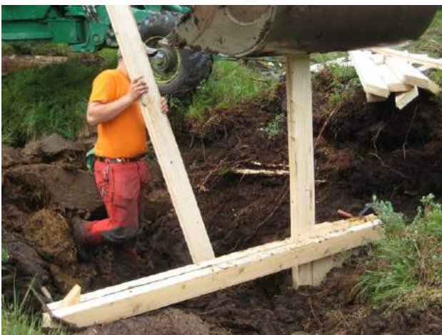
Die Spundbretter werden vor Ort abgeschragt und mit der Baggerschaufel zwischen den Führungsbalken/Zangen bis zu 3 Meter tief hinuntergedrückt, um die vor 100 Jahren angelegten Entwässerungsgräben einzustauen. Der Graben wird mit Torf eingedeckt und mit der vorher vorsichtig entfernten Vegetationsschicht zugedeckt.
