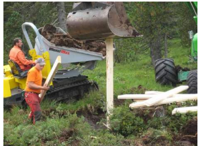
Die Spundbretter werden vor Ort abgeschragt und mit der Baggerschaufel zwischen den Führungsbalken/Zangen bis zu 3 Meter tief hinuntergedrückt, um die vor 100 Jahren angelegten Entwässerungsgräben einzustauen. Der Graben wird mit Torf eingedeckt und mit der vorher vorsichtig entfernten Vegetationsschicht zugedeckt.
