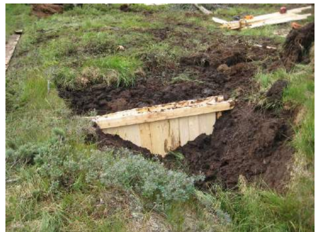
Die Spundbretter werden vor Ort abgeschragt und mit der Baggerschaufel zwischen den Führungsbalken/Zangen bis zu 3 Meter tief hinuntergedrückt, um die vor 100 Jahren angelegten Entwässerungsgräben einzustauen. Der Graben wird mit Torf eingedeckt und mit der vorher vorsichtig entfernten Vegetationsschicht zugedeckt.
